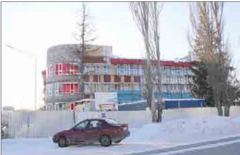
Недостроенная школа в Горьковском.
