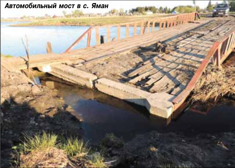
Автомобильный мост в с. Яман
