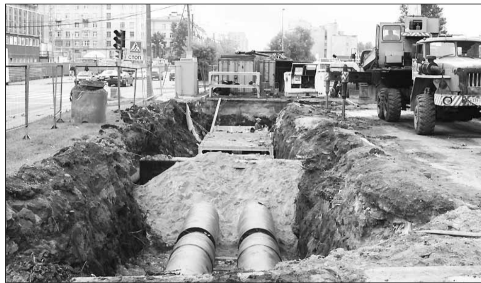
НА СНИМКЕ: Износ магистральных тепловых сетей в ЖКХ – 60%.
